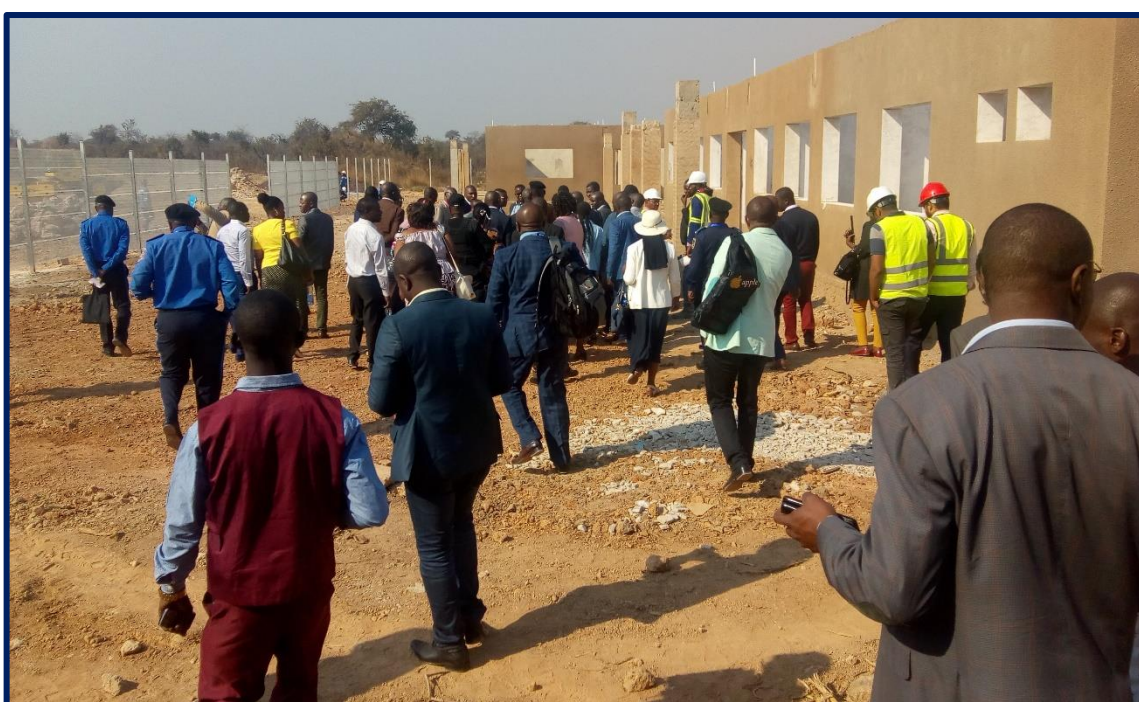
Figure 3.1. Visite guidée du chantier du Centre de Négoce de Musompo
